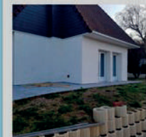
ISOLATION par l'extérieur avec ENDUIT
